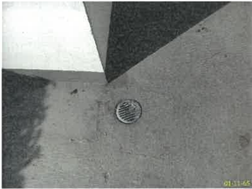
ภาพที่ 2.2-24 ตะแกรงครอบท่อระบายน้ำโครงการ
