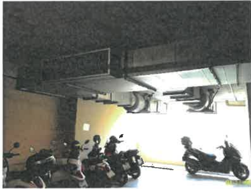
ภาพที่ 2.2-4 พัฒนาระบายอากาศที่จอดรถ
